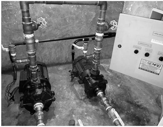
Conjunto motobomba, constituído pela bomba centrífuga, motor e quadro de comando<sup>6</sup>
